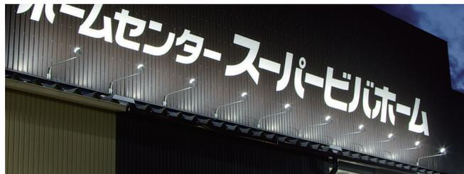
既存のバラストレス水銀灯の器具を利用して取り付けられる電球タイプ
