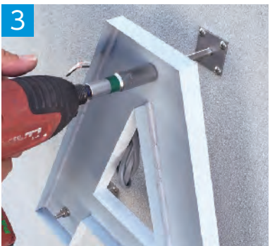
3 箱文字を差し込みナットで固定し、完成です。
