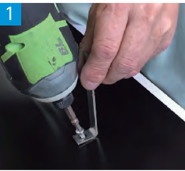
1 壁面にL型金具をビスで固定します。
