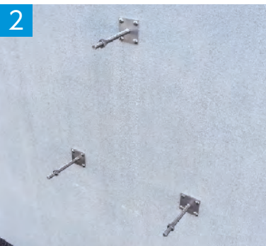
2 浮かし寸法位置までナットをいれておきます。
