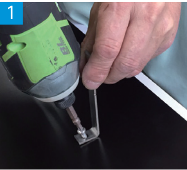
1 壁面にL型金具をビスで固定します。
