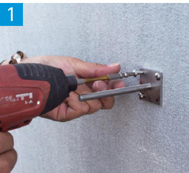
1 座付ボルトを壁面にビスで固定します。
